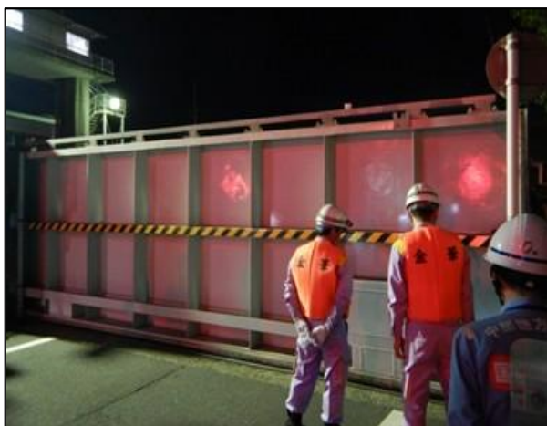
材木町陸閘の閉鎖状況
